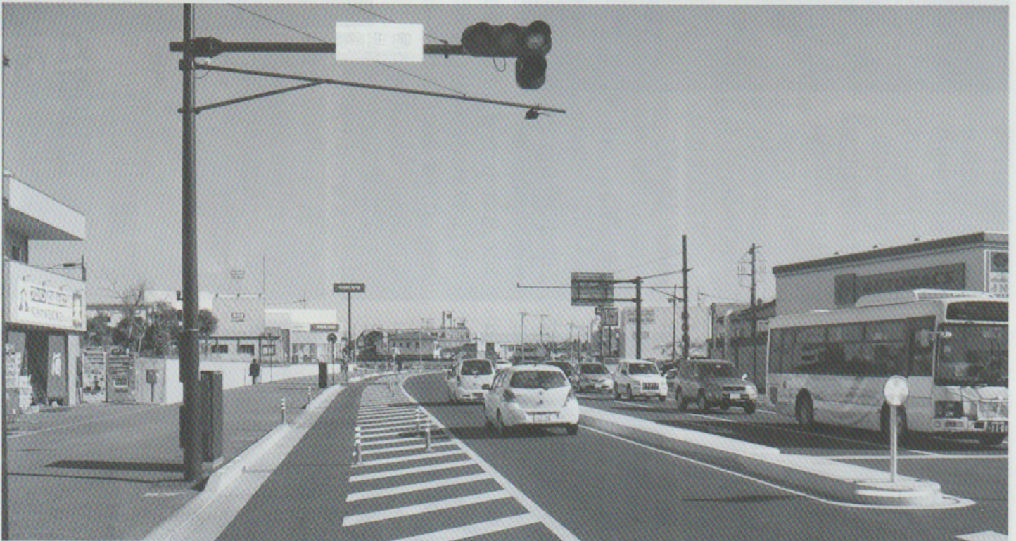
大谷街道拡幅工事(桜通り~宮環)のうち整備済みの駒生立体交差点付近(西中丸)
